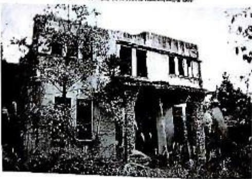
荒廃した旧愛宕鋼索鉄道山上駅跡
