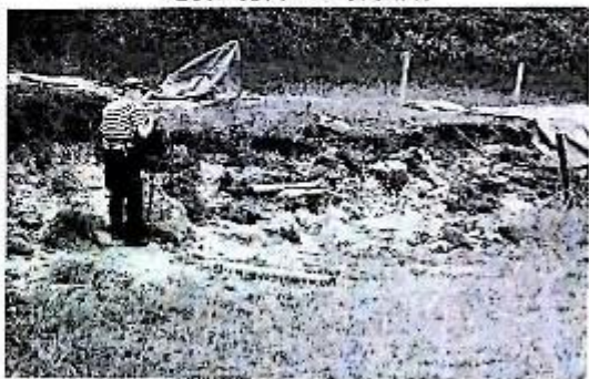
地表に露出した野島断層
