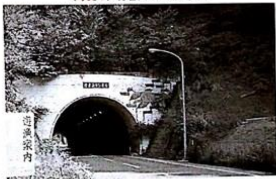
(写真1) 行者山トンネル南口
