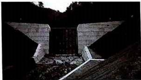
パイプ式堰堤
